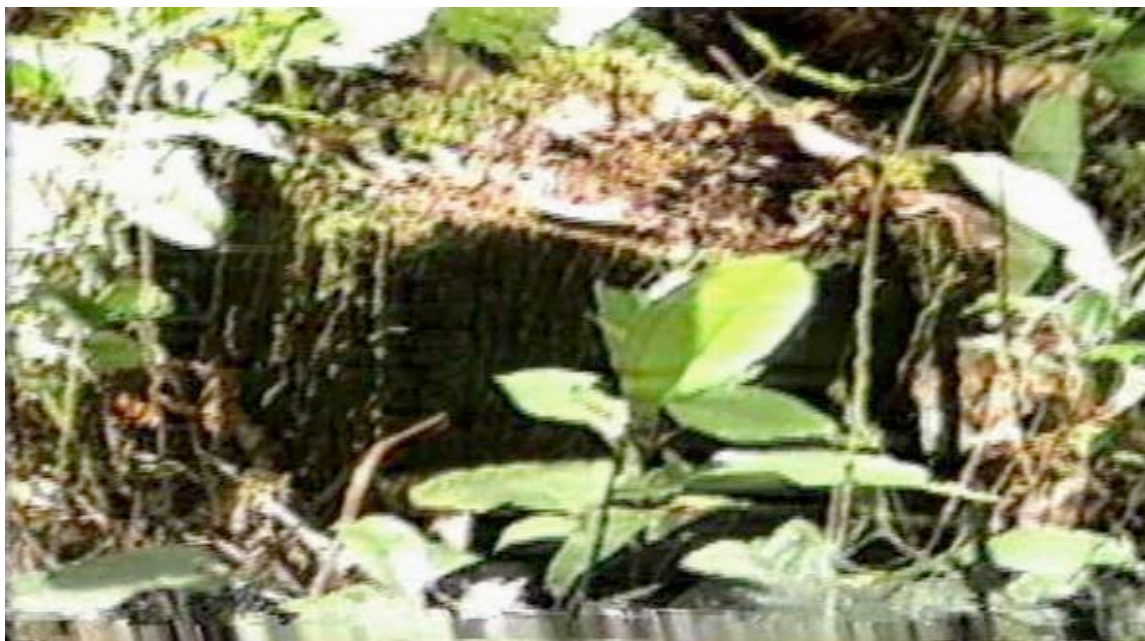
Restos da casa de João Tirloni no Garabel (fotografia do ano 1998)
