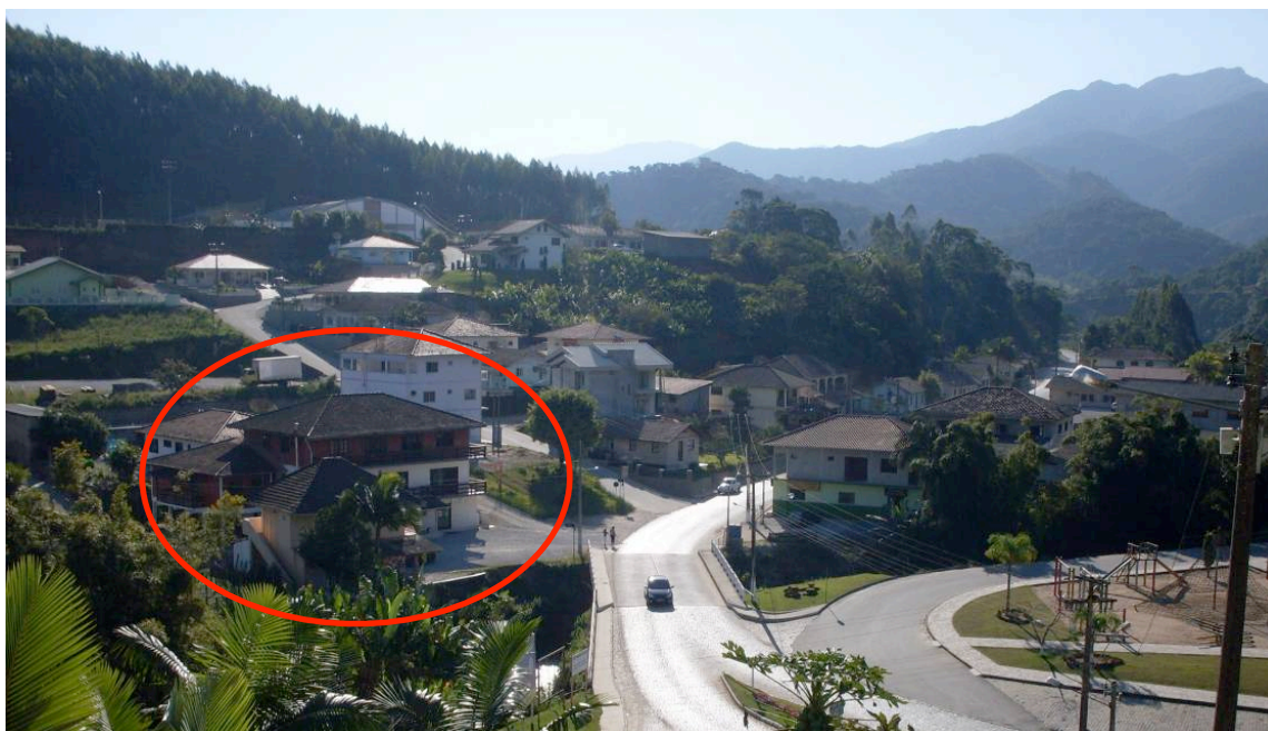
Zona onde estava localizado o empório de Albina e João Tirloni (fotografia do ano de 2009)
